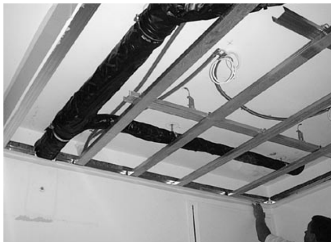
Sanierungsarbeiten im Untergeschoss der Siedlung Gehrhalde
